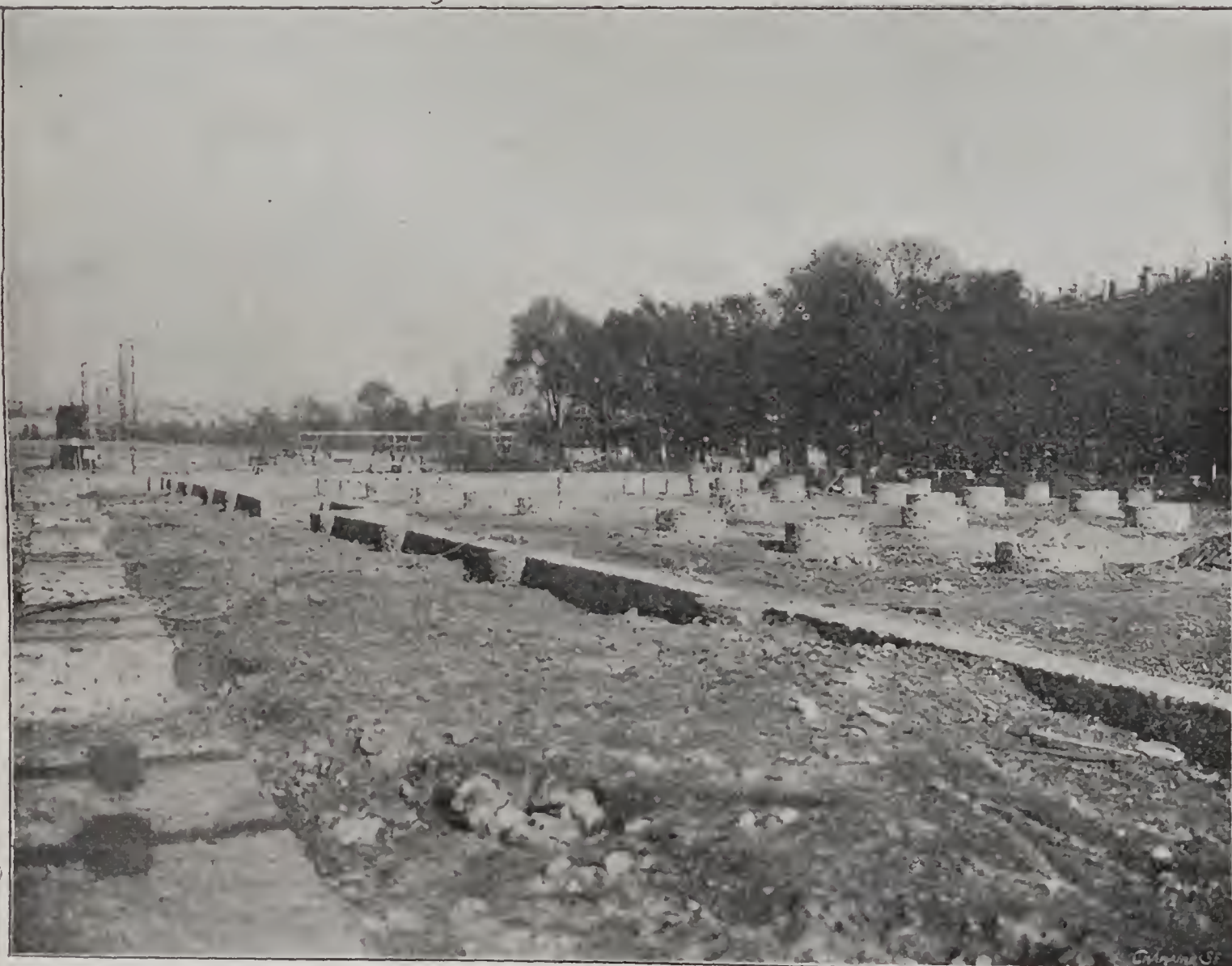
LES CHANTIERS DES INVALIDES. — Rigoles et fondations.
